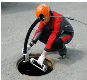
Закрепить в колодце направляющую трубу при помощи фиксатора
