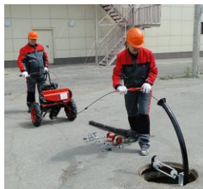
При помощи толкателя плавно подавать прочистные стержни в направляющую трубу, одновременно перемещая вперед привод
