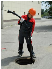
Опустить в колодец направляющую трубу с прочистными стержнями и насадкой, направить в очищаемый трубопровод
